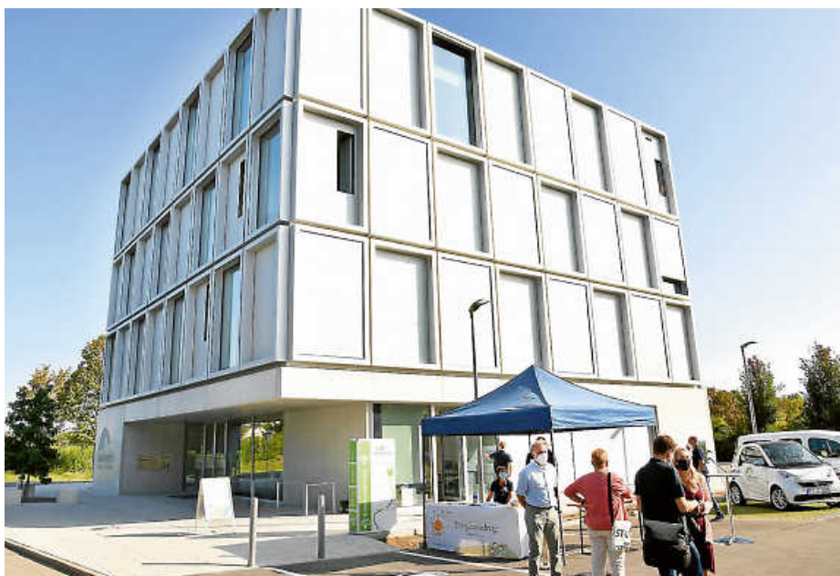
Gerd Alsheimer, Sachgebietsleiter Energiedienste/Haustechnik bei den Stadtwerken LE, vorne links, im Gespräch mit interessierten Bürgern. Im Hintergrund die Neubaufassade mit vorwiegend geschlossenem außenliegenden Sonnenschutz zur Verminderung des Wärmeeintrags in das Gebäude.
