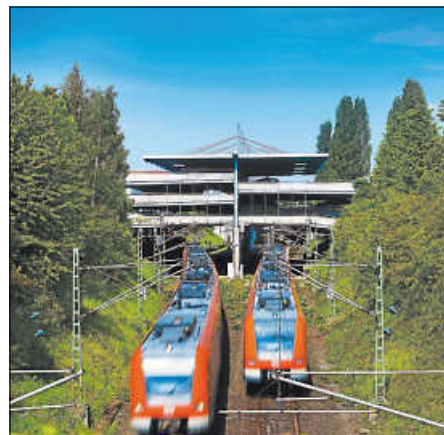
Foto: Stadtwerke LE
