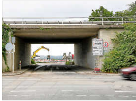
Die B27-Unterführung ist eine Engstelle und trennt die zukünftige Stadtbahnhaltestelle vom Ort. Foto: Bergmann
