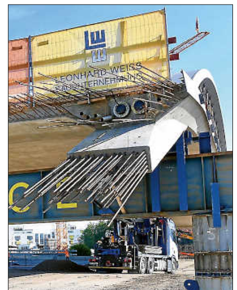
Spezialfahrzeuge brachten die Brücke an ihren Bestimmungsort. Das Bauwerk ruht vorerst auf provisorischen Stützen. Fotos: Bergmann/Krämer
