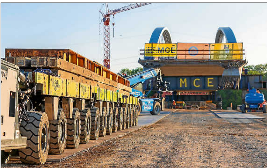
Spezialfahrzeuge brachten die Brücke an ihren Bestimmungsort. Das Bauwerk ruht vorerst auf provisorischen Stützen. Fotos: Bergmann/Krämer
