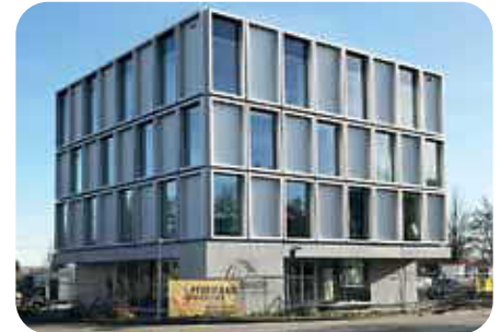
Januar 2020: aktuelle Ansicht des Neubaus
