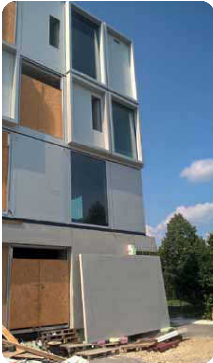
August 2019: Einbau der großen Fensterflächen
