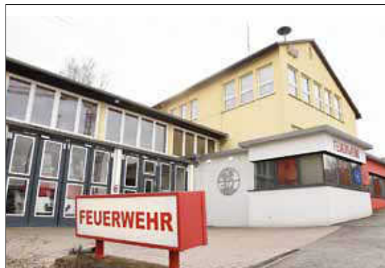
Das Feuerwehrhaus an der Weidacher Steige ist nicht mehr sanierungsfähig. Foto: Bergmann
