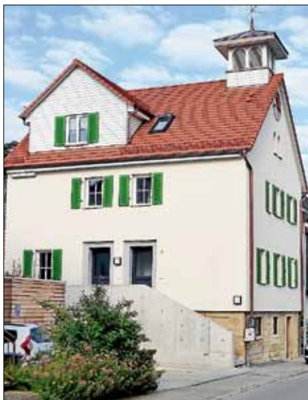
Das Gebäude heute nach der Sanierung.
