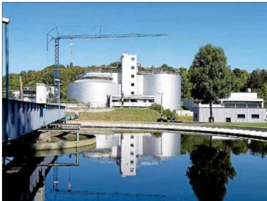
Blick über das Nachklärbecken auf die Faultürme.
