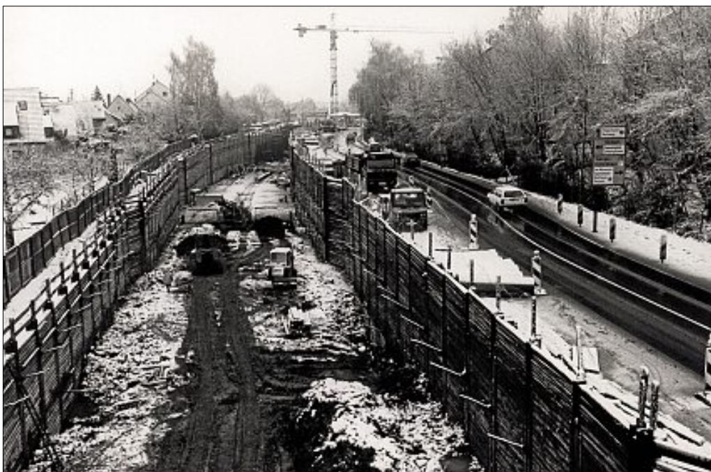
Die S-Bahn-Baustelle zwischen Ober- und Unteraichen im November 1990.
