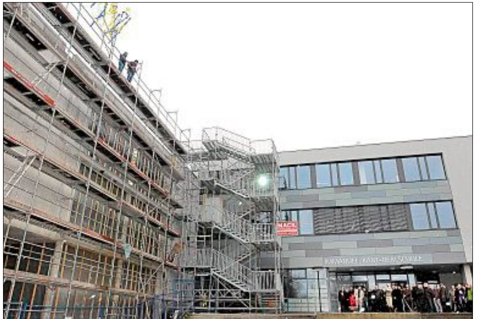
Bis zum neuen Schuljahr wird der Anbau bezugsfertig sein.
